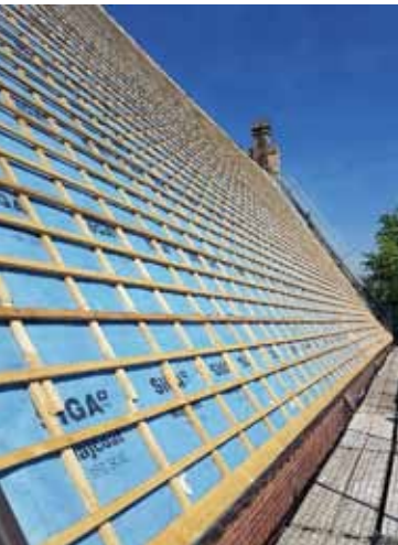
Eine Dachfläche während der Neueindeckung Das geöffnete Dach während der Bauphase
