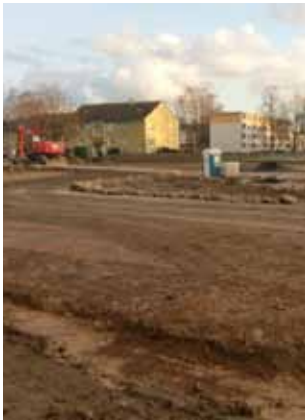
Noch ist nicht viel zu erkennen. Aber das Gelände an der Kolbstraße ist nun zur Bebauung vorbereitet.
